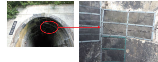
女満別トンネル[経年、地山の凍結による変状] ○経年111年(1912(大正元)年完成) ○石北線 女満別～呼人間
