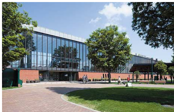
岩見沢市の公共施設としてセンターホールを配置した岩見沢複合駅舎。建物内には北海道教育大学岩見沢校のサテライトスペース「I-BOX」もある。撮影＝小川重雄
