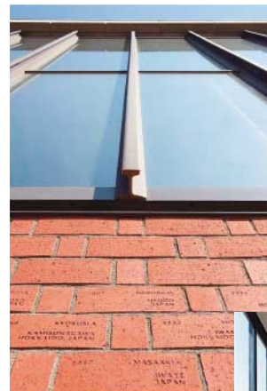
(右下)約100mの吹き抜け空間。 (左)古レールと刻印レンガ。
