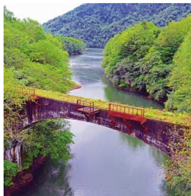
国道273号から見える第三音更川橋梁。往時の優美さを伝えている
