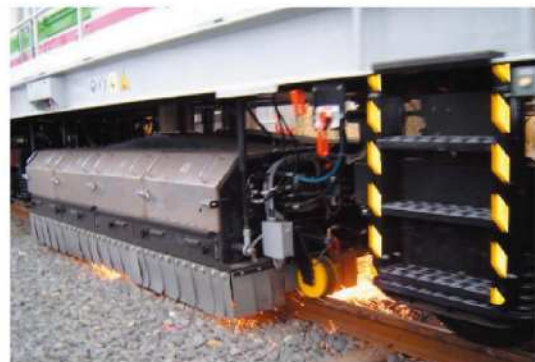
レール削正の状況
