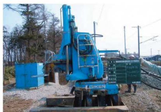
低騒音・低振動型のサイレントパイラー
