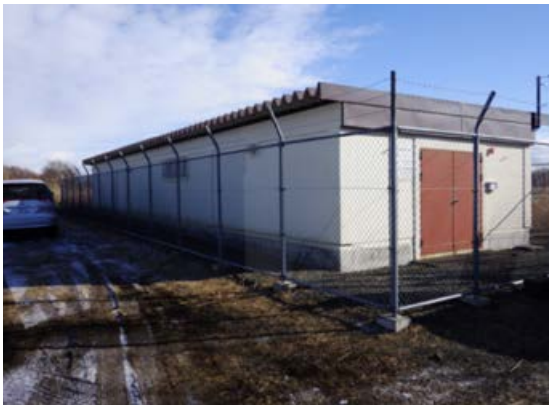
PCB廃棄物の保管庫外観(東追分)
