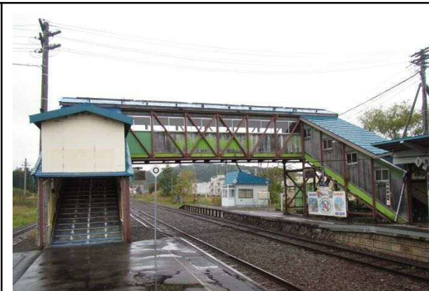
軟弱地盤上の乗換跨線橋
