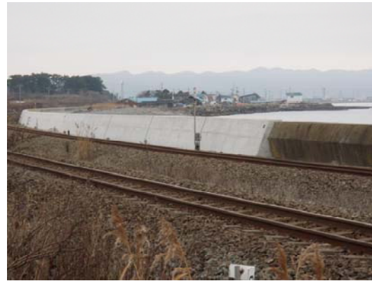
(護岸 (函館線 山越駅～八雲駅間))
