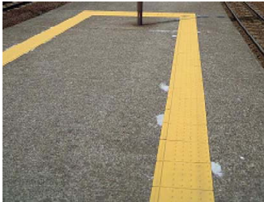
(内方線付点状ブロックの新設)
