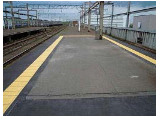
(内方線付点状ブロックの張替え)
