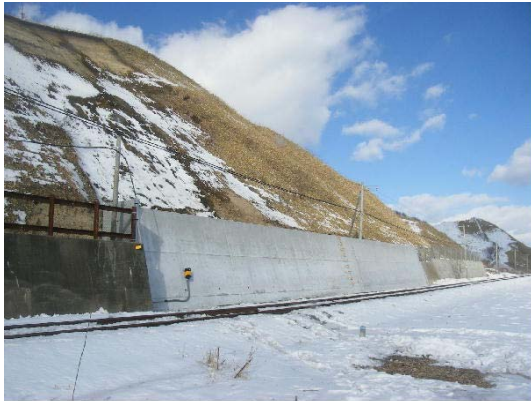
(土留擁壁 (根室線 音別駅～古瀬駅間))
