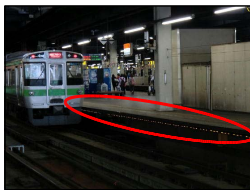
《LEDはホーム下に設置しています (写真は札幌駅)》
