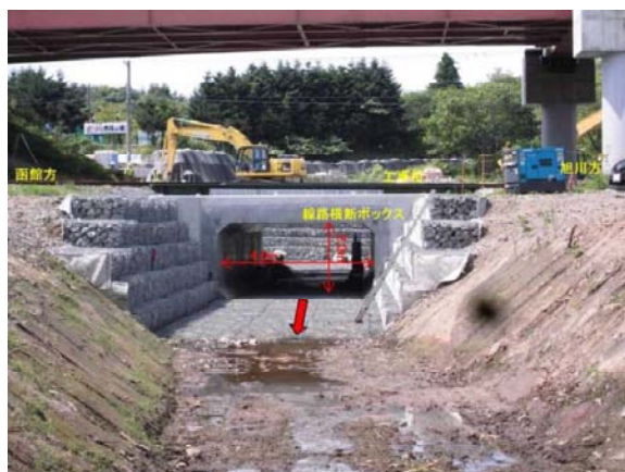
完成した非常導水路（平成26年8月完成）
