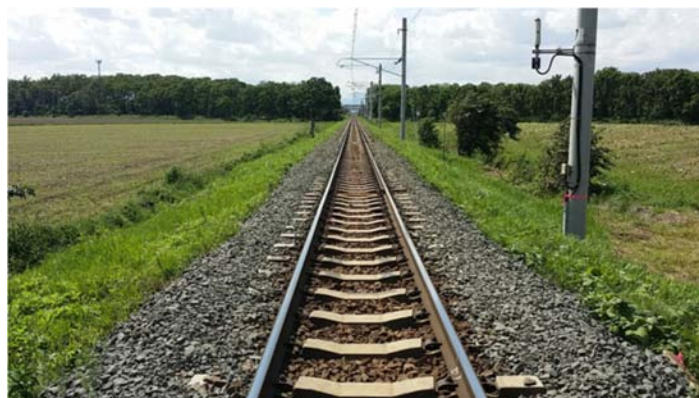
P Cマクラギ化（札沼線）
