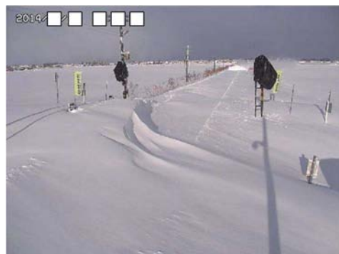
降雪モニターカメラ映像による 吹き溜まり状況の把握
