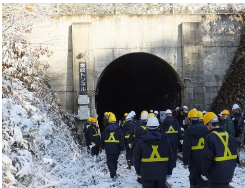
第10回JR北海道再生推進会議（平成28年10月24日） 常紋トンネルにおける老朽土木構造物の現地調査
