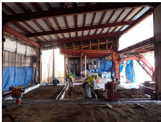
基礎工事状況
