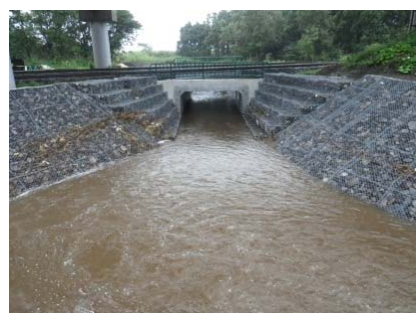
函館線山越～八雲間 非常用水路新設後の状況
