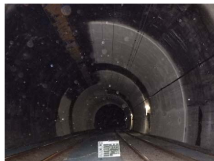
断熱防水板設置後の状況
