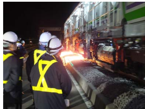
第11回JR北海道再生推進会議（平成29年5月24日） 北海道新幹線の木古内保守基地での レール削正作業の現地調査
