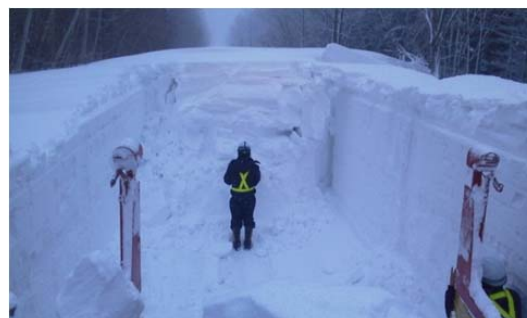
風雪により閉ざされた釧網線の線路 （平成 27 年 2 月 16 日 川湯温泉～緑間）
