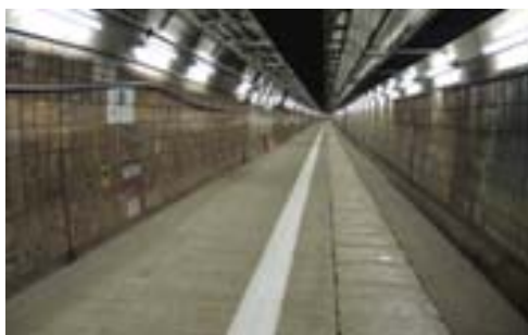
吉岡定点下り線誘導路のトンネル床誘導線
