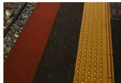
内方線付き点状ブロック
