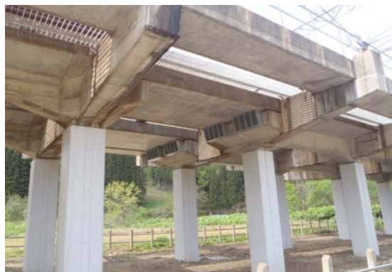
RCラーメン高架橋柱の鋼板巻き補強
