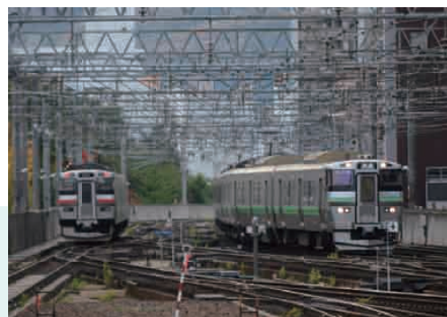
札幌駅構内に敷設された分岐器。分岐器は一般的に「ぶんぎき」と読みますが、鉄道の現場では昔から「ぶんぎき」と呼んでいます
