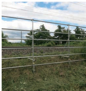
鹿侵入防止柵
